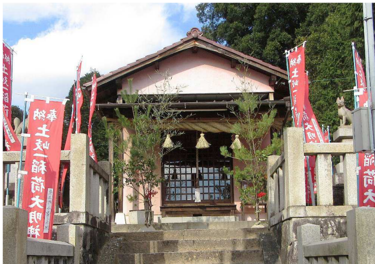
今年正月の土岐一稲荷神社社殿 間もなく解体されます
