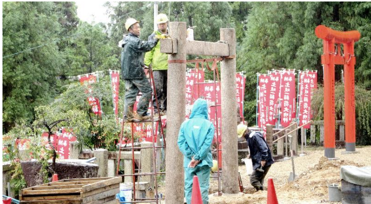
耐震補強された鳥居の組み立て
