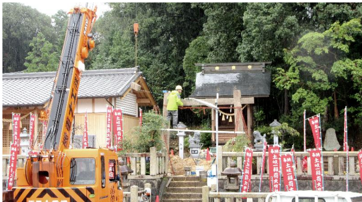
耐震補強された鳥居の組み立て
