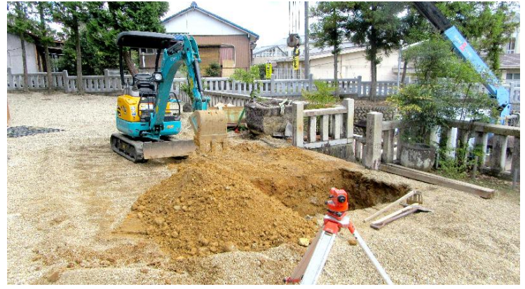
コンクリート基礎用穴掘り (9月3日)
