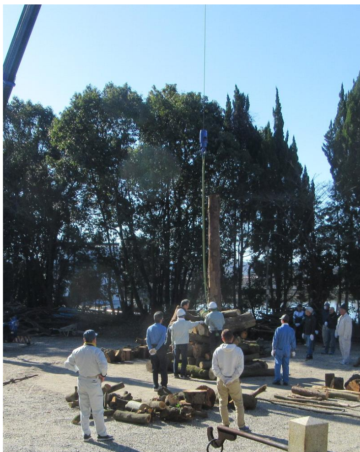
クレーンを使用して篝火を組上げ
