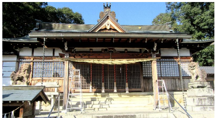
大しめ縄の取り付け完了です
