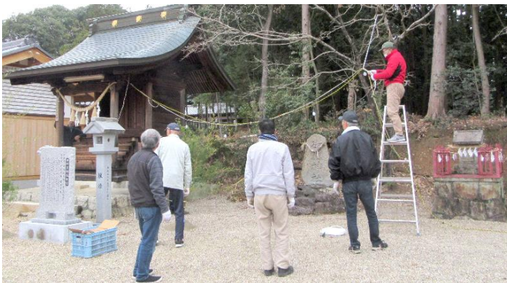
照明用配線・電球を取り付ける
