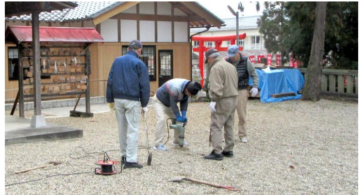
境内の門松を立てる杭の穴を電動工具で開ける
