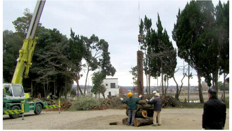
クレーンを使用して篝火の組上げ
