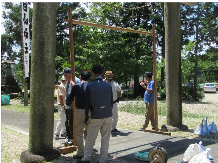
木枠の組み立て
