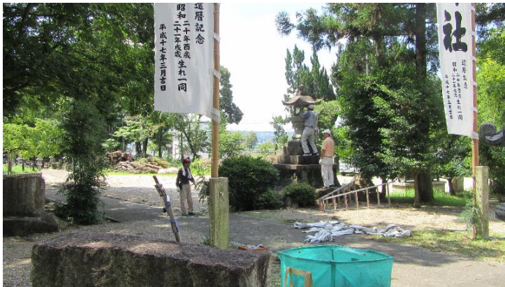
照明の配線作業
