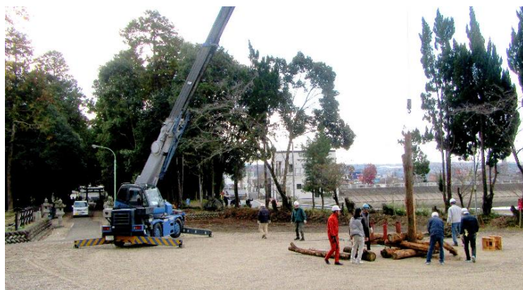
クレーンを使用して篝火の組上げ
