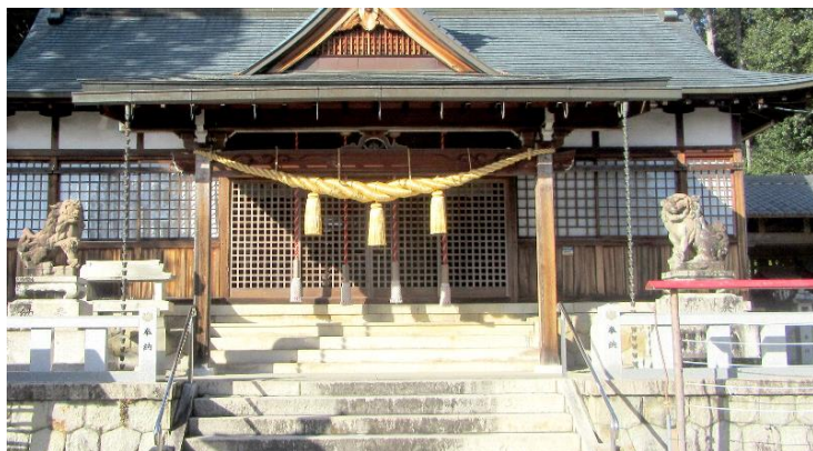
立派な大しめ縄が 設置完了
