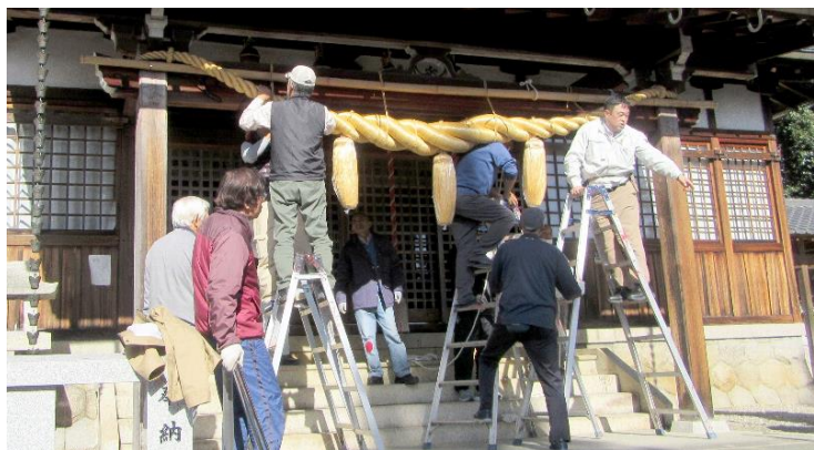
大しめ縄の設置作業
